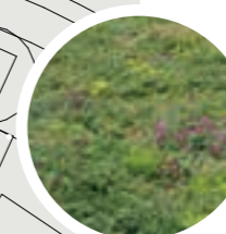
BERGING Met sedum (groen) dak
