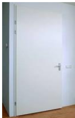
Hardhouten binnendeurkozijn zonder bovenlicht met opdekdeur
