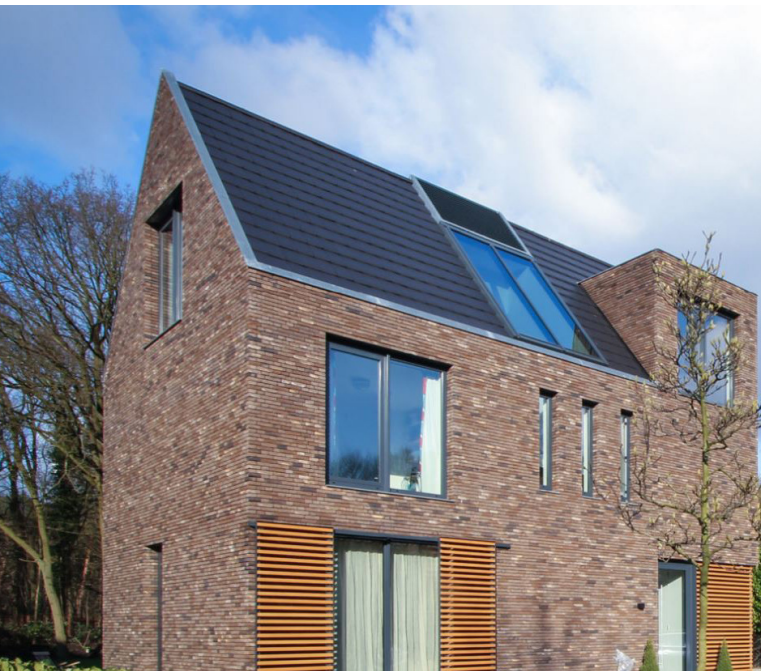
geen overstek + ingetogen detaillering
